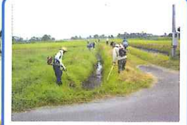
水路の除草作業
