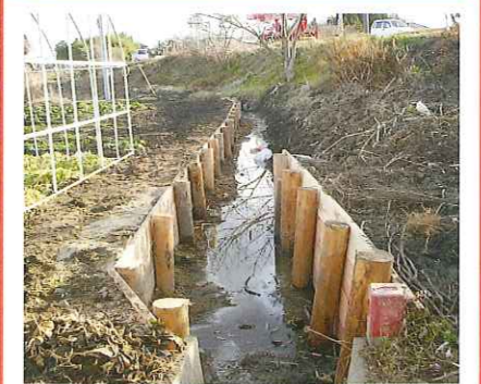
機械浚渫及び板柵補修
