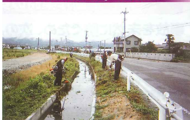
【水路の保全管理】 野地地区
